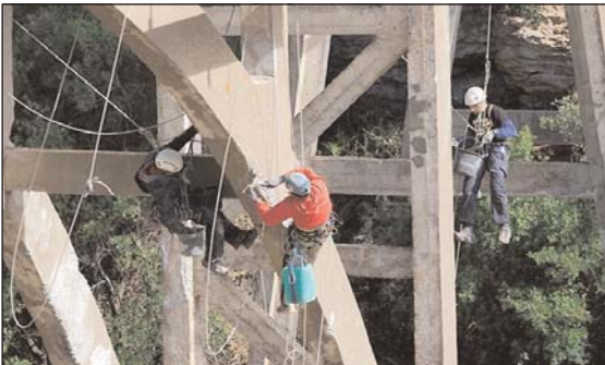
La restauration du pont de Mayranne
